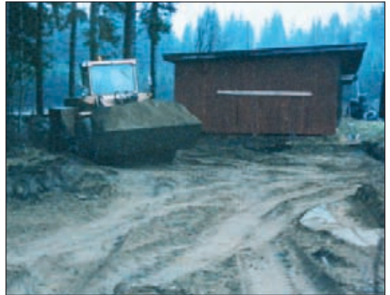
Uuden pistooliradan pohjustustyöt.
